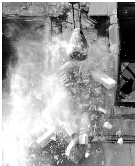
slopen met een sloopkogel
